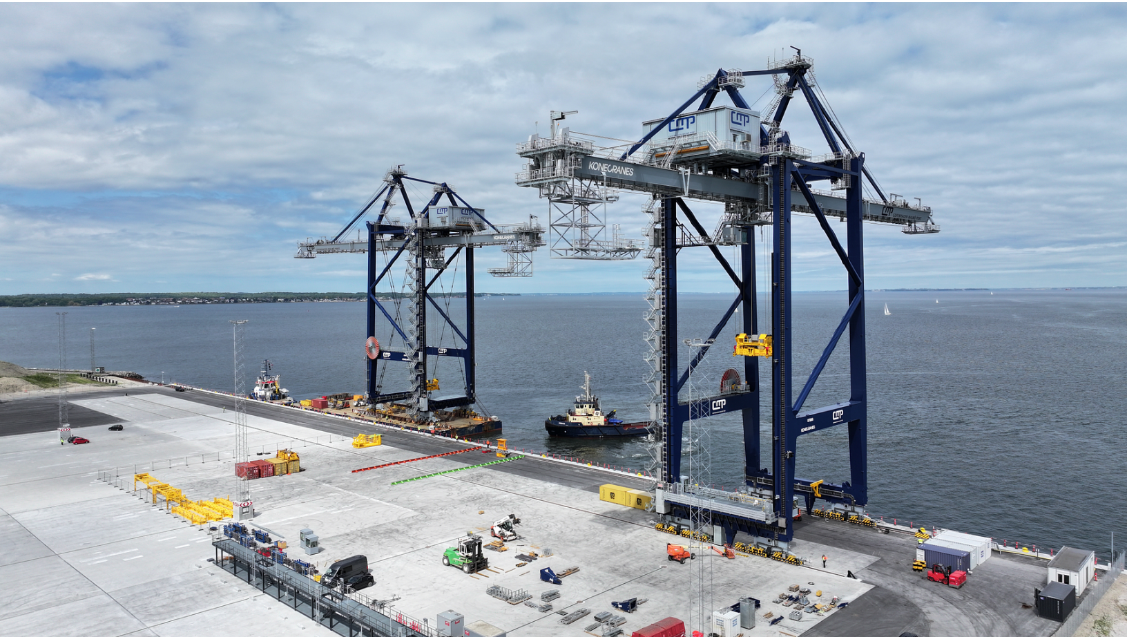
CMP modtager anden STS-kran
